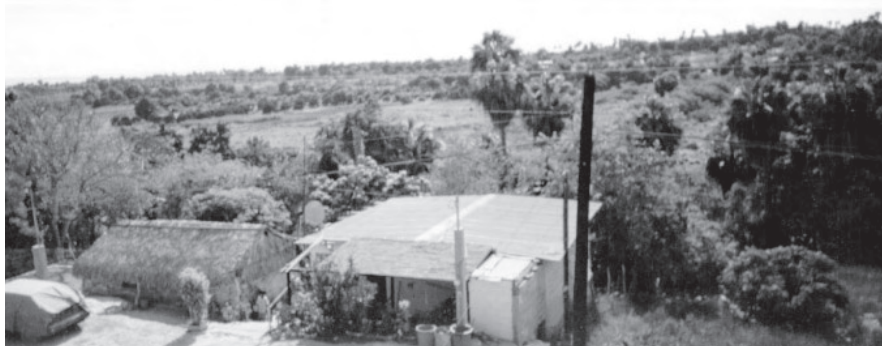
1. Casa en construcción con nuevos materiales, al lado de la casa de adobe y techo de palma.
