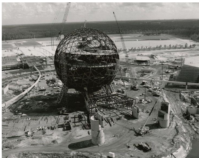
Construcción de Spaceship Earth a finales de 1970.
